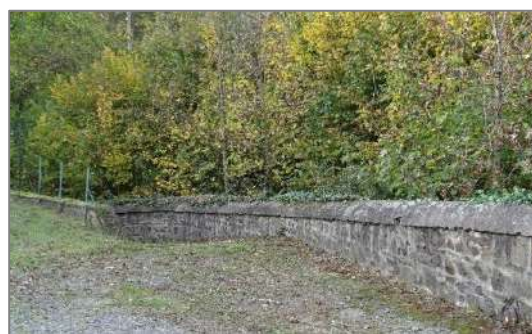
Mur bordant le chemin d'accès au niveau inférieur du bâtiment
