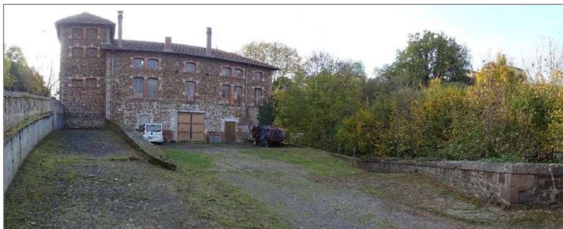
Tènement accompagnant le bâtiment des anciens ateliers
