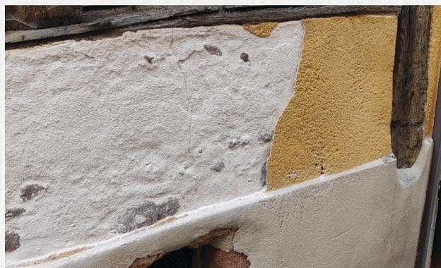
Exemples d'enduits monocouche non adhérents au support ancien; dans le cas 2, les remontées capillaires ont provoqué le décollement de l'enduit monocouche.
