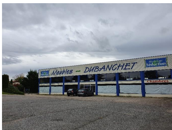
Bâtiment de l'ancien magasin de meubles
