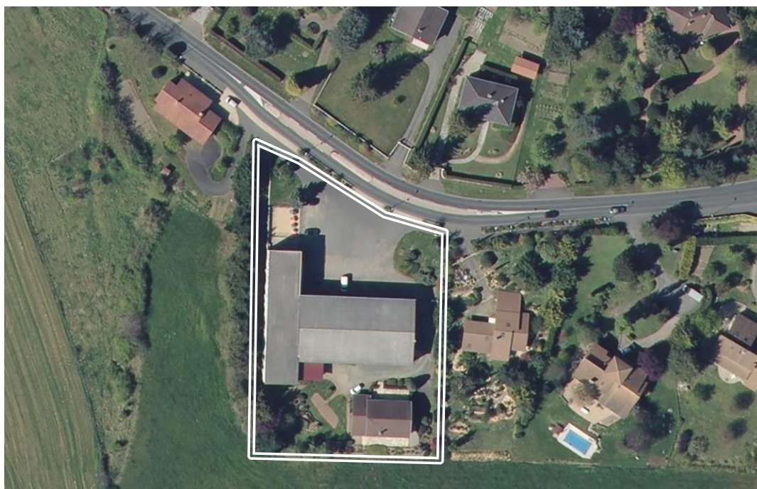
Photographie aérienne du secteur UCs
